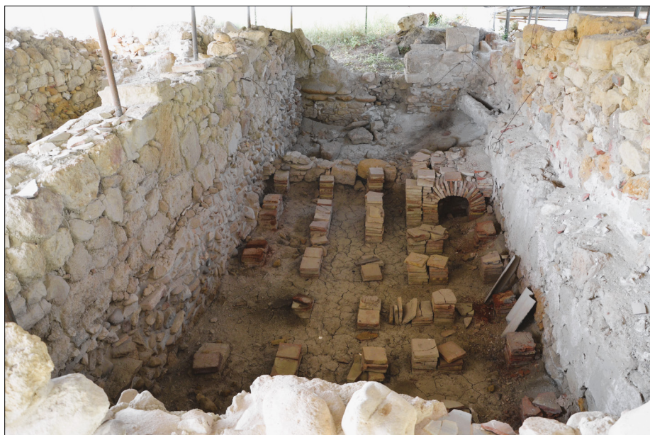
Fig. 8. Realmonte (AG), villa marittima. ambiente termale con suspensurae (foto Autore).
