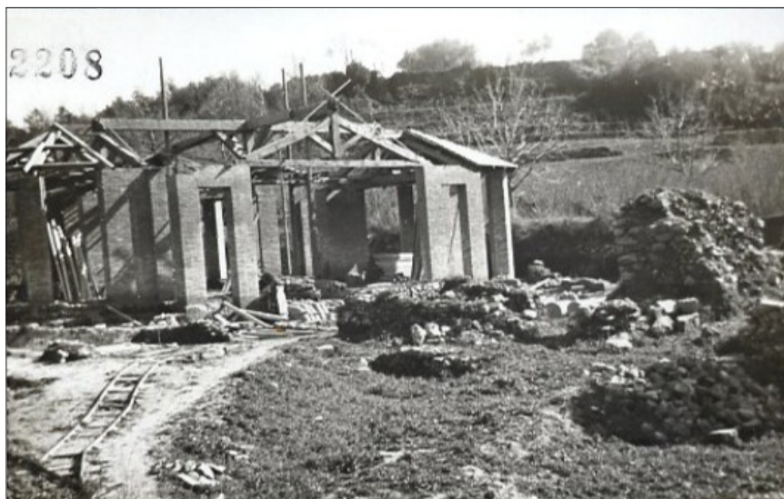
Fig. 8. 1941-1942, la copertura del triclinio progettata da P. Gazzola in fase di costruzione (Soprintendenza per i Beni Culturali e Ambientali di Enna).
